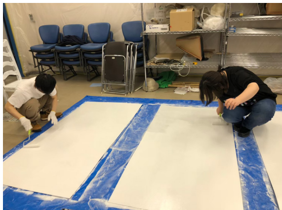
図7 合板の塗装作業
